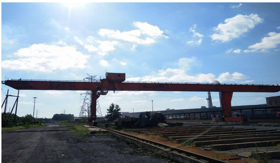
运输处型钢成品组中间库 2#龙门吊车悬臂体现状
