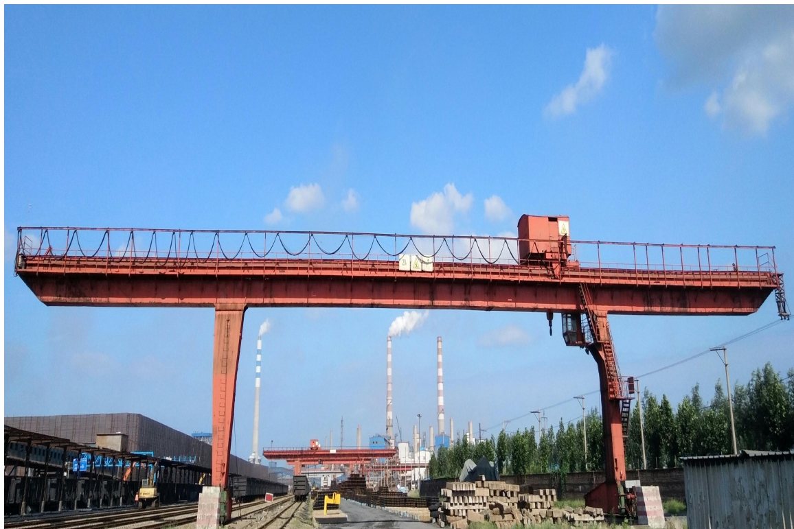
运输处型钢成品组中间库 2#龙门吊车体现状
